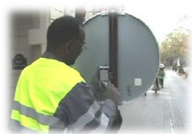
La Ville de Paris avait besoin de connaître en temps réel l'état de la signalisation horizontale et verticale de la voirie. Elle a fait développer une solution basée sur une identification par RFID, une géolocalisation par GPS et une cartographie sous Google Map.
