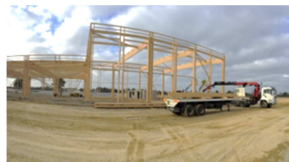
Etat d'avancement des travaux du siège social d'AltéAd (85)
