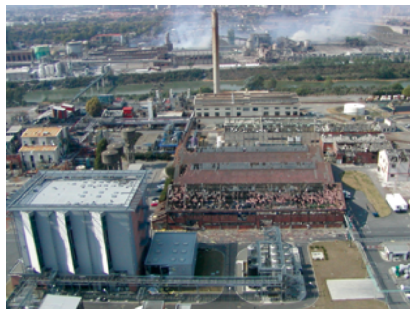
Ci-dessous, après l'accident, la partie centrale de l'usine SNPE, avec la chaufferie au premier plan.
