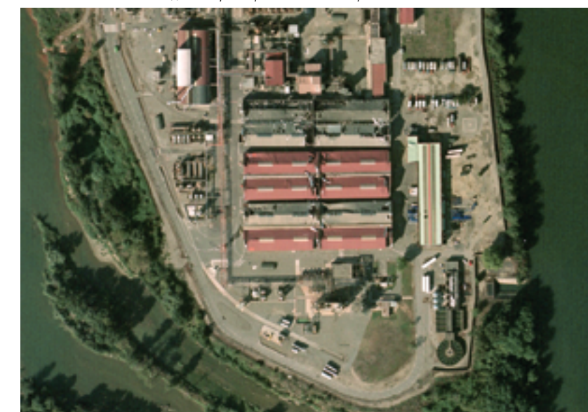
Vue des toits de la partie sud de SNPE, ils sont arrachés vers l'extérieur et cela coïncide avec les anomalies de pression (ateliers numérotés en rouge sur le plan ci-dessous), donc cet effet ne peut provenir de l'explosion du 221
